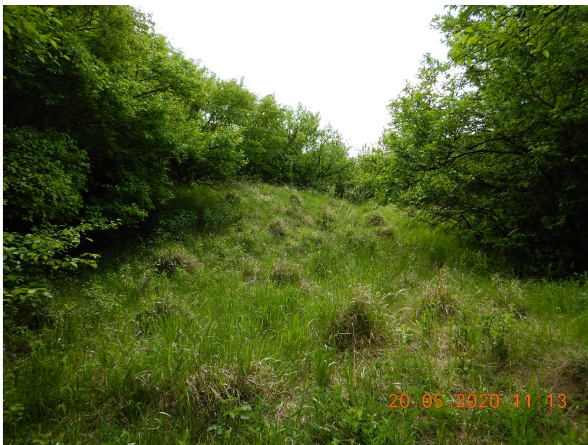
Widok na czoło osuwiska
